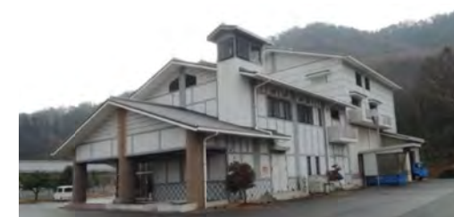
矢掛浄化センター 管理棟 (出典) 矢掛町「下水道事業の広域化・共同化」
